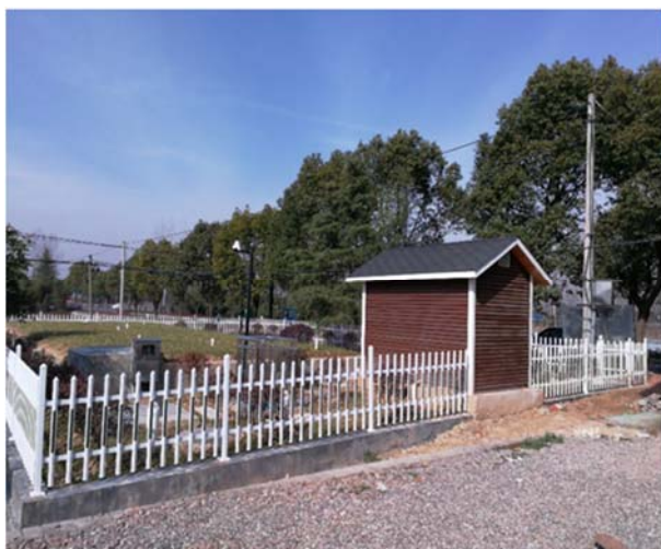
浙江省义乌市佛堂镇芦塘下村生活 污水处理站（80 吨/天）
