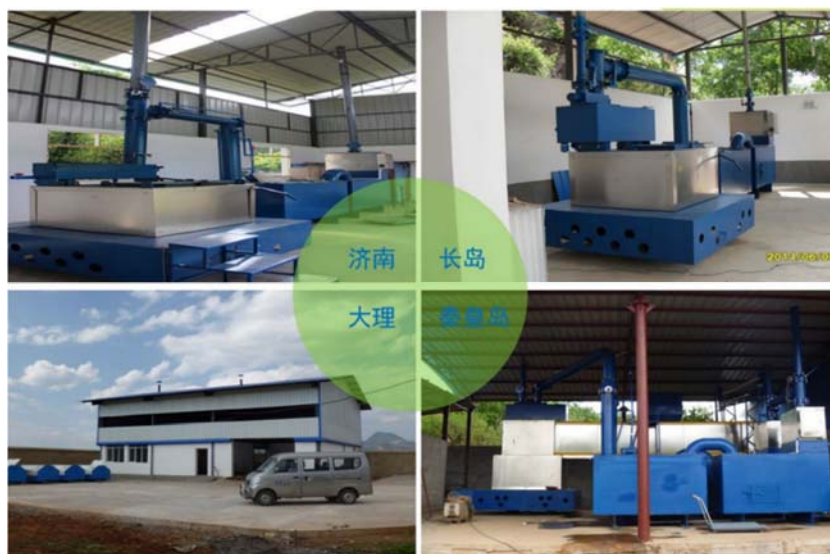
部分实际应用现场图片
